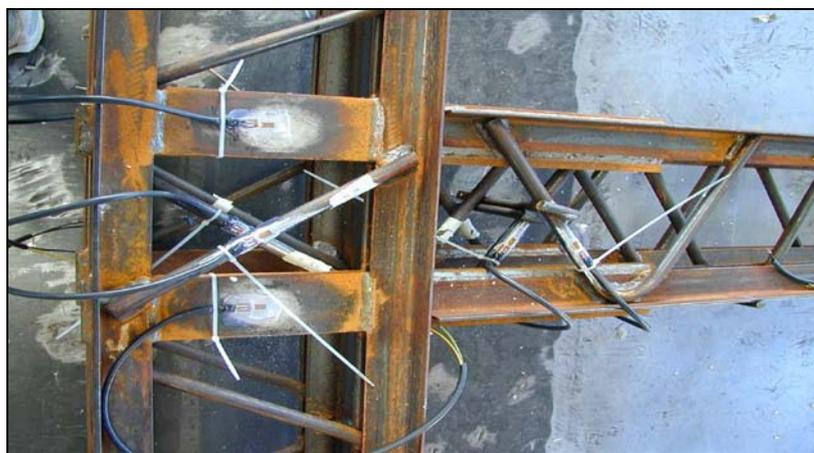
Figura 73. Sistema metallico nodo trave-colonna prima del getto di calcestruzzo.
