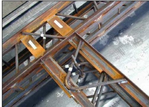
**Figura 28.** Particolare del sistema metallico in corrispondenza del giunto trave-pilastro.
