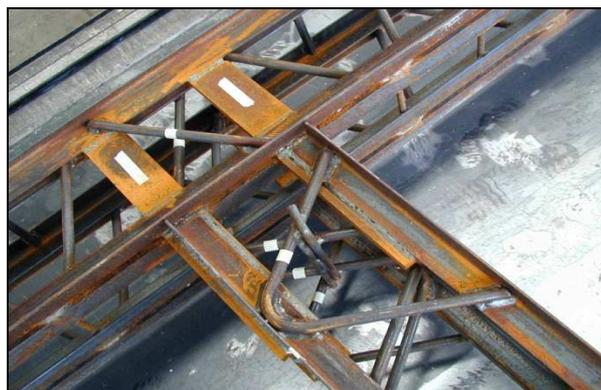
**Figura 23.** Particolare del sistema metallico in corrispondenza del giunto trave-pilastro
